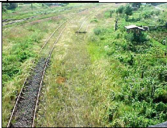
Obr.1. Pohled z mostu do nádraží Scinawka Srédnia
