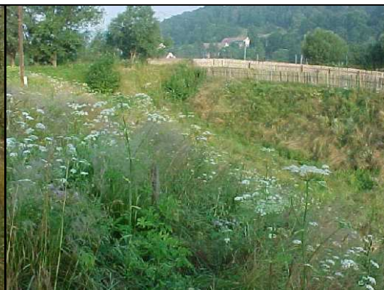
Obr. 19 Zasypaný zářez (bod 46)
