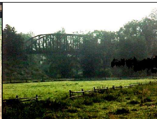
Obr.23 Celkový pohled na most
