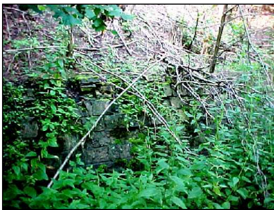
Obr. 13 Opěrná zed' (bod 32)
