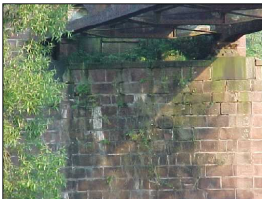
Obr. 22 Pilíř mostu–směr ke st. hranici
