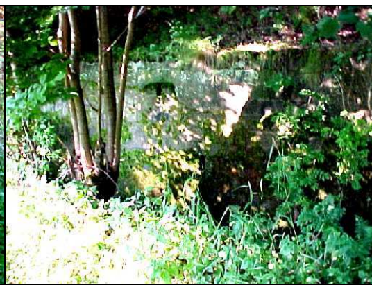
Obr. 14 Opěrná zed' (bod 33)
