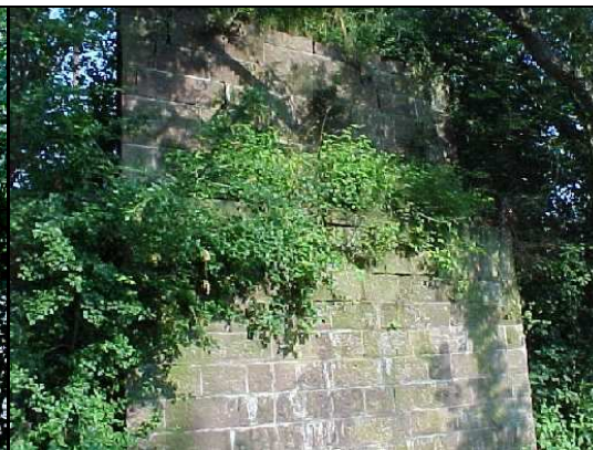
Obr. 12 Pilíř mostu přes Stěnavu – strana k Tlumaczówu
