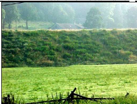
Obr. 24 Násep od mostu ke st. hr.
