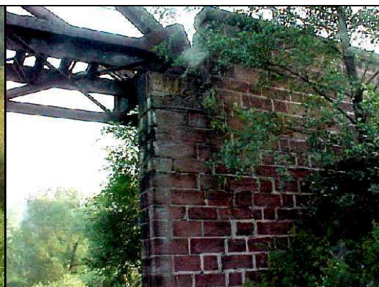
Obr. 21 Pilíř mostu v Tlumaczówe
