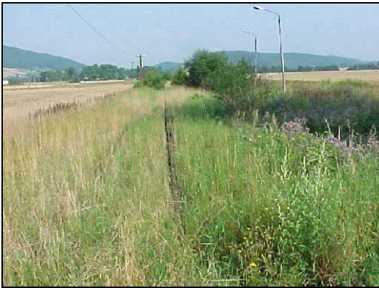
Obr5 Zhlaví výhybny směrem ke Střední Stěnavě
