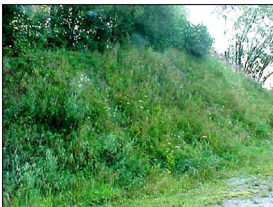
Obr. 9 Přerušovaný násep (snesený most nad silnicí) strana k Str. Stěnavě
