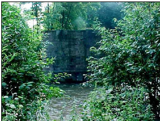
Obr. 11 Střední pilíř mostu přes Stěnavu v Horní Stěnavě
