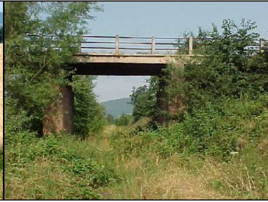
Obr. 4 Nadjezd přes původní trať (bod 4)
